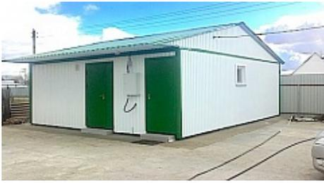
Молочный мини-завод «Маком М-3000» представляет собой здание модульно-контейнерного типа, состоящее из 6-ти модулей, с системами отопления, вентиляции, водо- и электроснабжения, кондиционирования и смонтированной внутри технологической линией по приёмке и переработке молока с выпуском готовой молочной продукции в индивидуальной упаковке.
